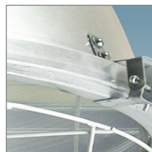
Крепление обечайки к отражателю
