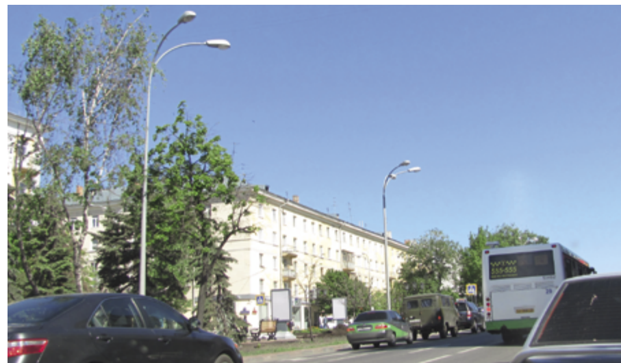
г. Ульяновск, освещение дороги
